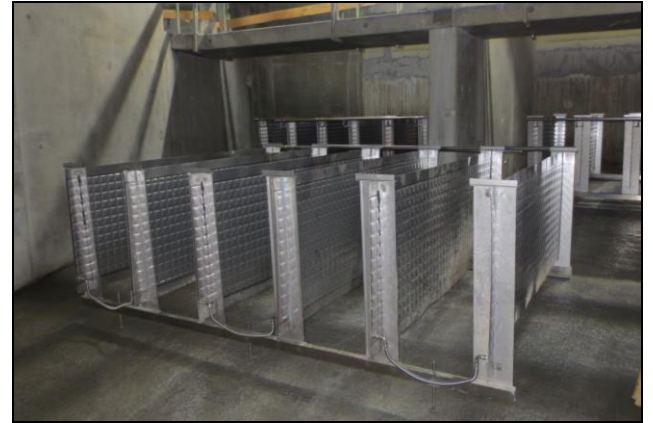
Abb. 2: Wärmetauscherplatten im Eisspeicher
