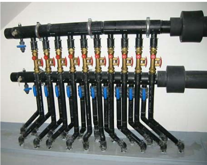
Einer der Sondenverteiler für die 34 Erdwärmesonden
