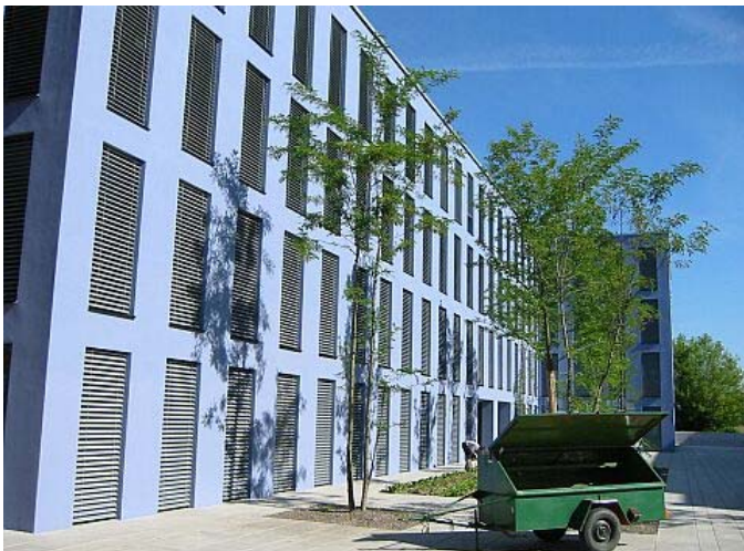
Ansicht der Fassade der Büros
