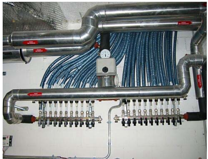
Einer der verschiedenen TABS-Verteiler im Zentrum Huob
