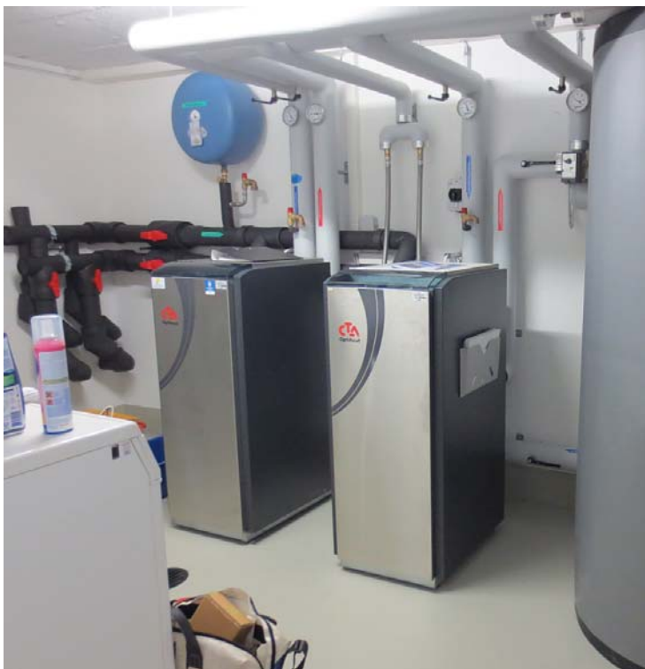
Neue Erdsonden-Wärmepumpenanlage mit 2 Wärmepumpen von CTA in Master - Slave - Schaltung
