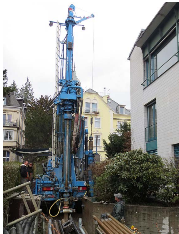
Bohrung in beengten Platzverhältnissen
