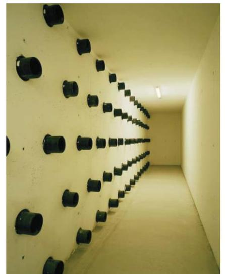
**Vergleich der Leistungsfähigkeit des Luft-Erdregisters mit 30cm und 20cm Rohrdurchmesser (links) und ausgeführtes Erdregister mit 20cm Rohrdurchmesser (rechts). Berechnung mit Programm WKM ([www.hetag.ch](http://www.hetag.ch)).**
