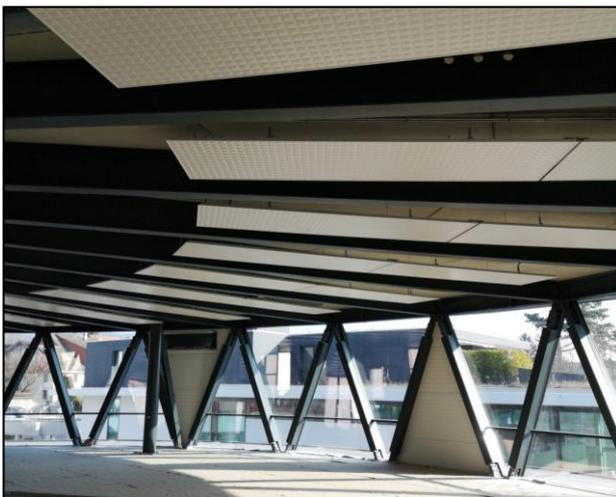
Abbildung 1-10: Deckenstrahlplatten im 1. OG
