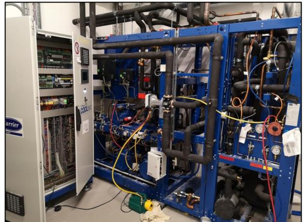
Abbildung 1-9: Kältemaschine Lebensmittelladen
