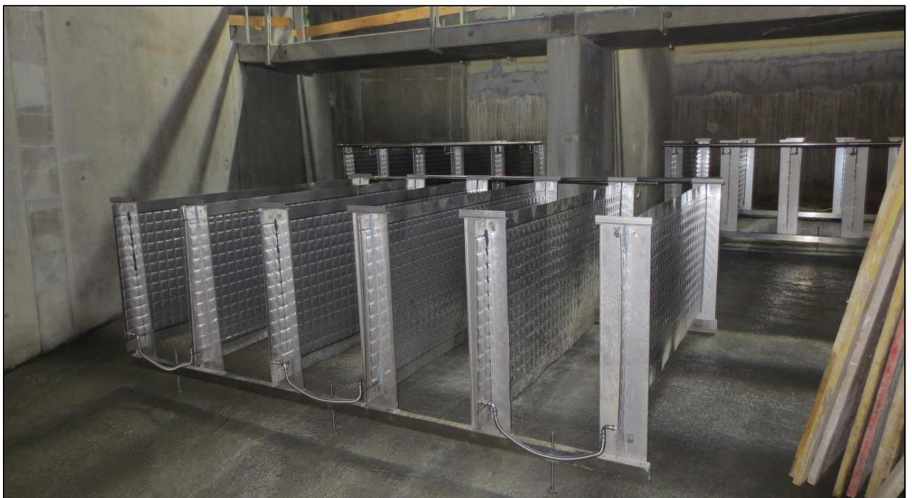
**Abbildung 1-5: Einbau der Wärmetauscherplatten von Energie Solaire SA.**
