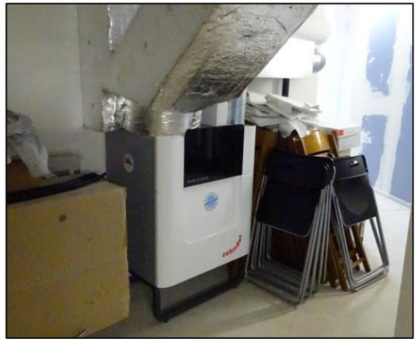
**Abbildung 1-13: Lüftungsgerät für Bürobereich**
