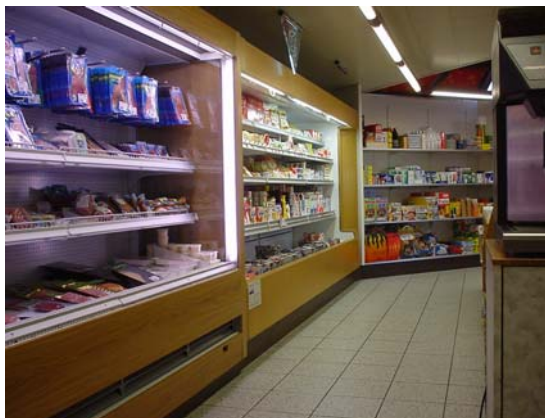
Bild 3.1: Kühlmöbel in der Beispielanlage (Foto: KWT AG).
