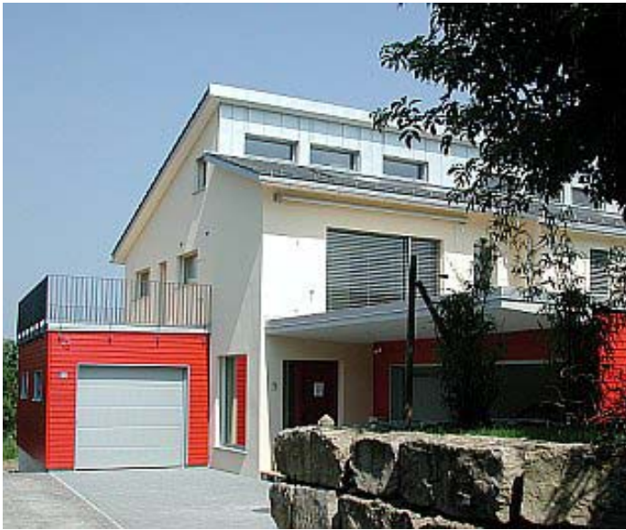
MINERGIE-P DEFH Haufland, Maur: Süd-Wes-Fassade
