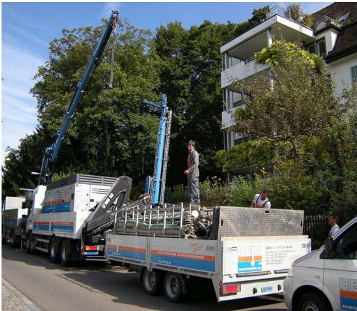
Bohrung in beengten Platzverhältnissen
