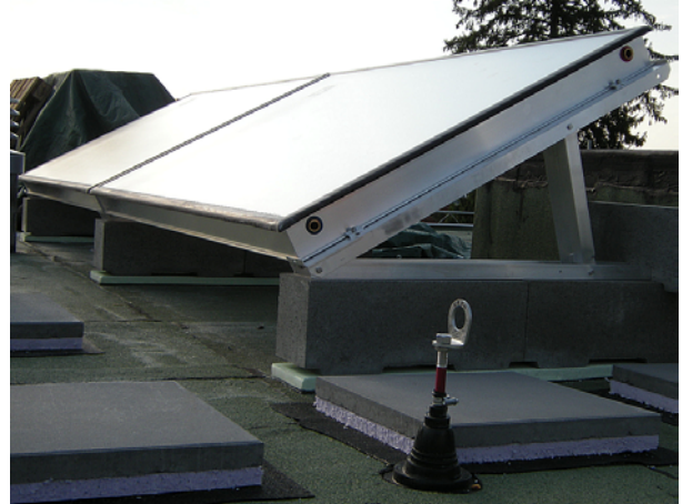
Auf dem Dach wurden 6 Kollektoren vom Typ Conergy Aldo 240H installiert.
