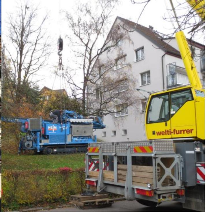
Abb. 4: Um Schäden an der Umgebung zu minimieren wird das Bohrgerät mit einem Pneukran zum Bohrort gebracht.
