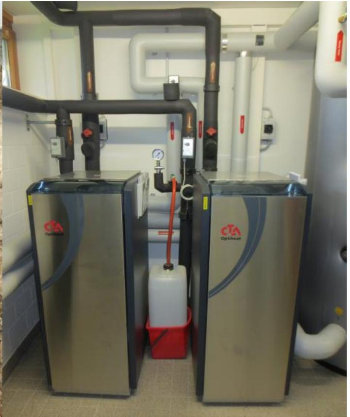
Abb. 6: Wärmepumpen in der klassischen Master-Slave-Schaltung (je 2 Stück pro Haus) mit Modbus-Schnittstelle zur übergeordneten Steuerung (Netlogger).
