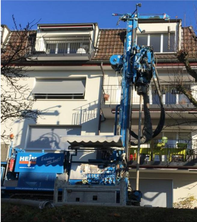
Abb. 3: Bohrung der Sonden durch Heim Bohrtechnik AG.
