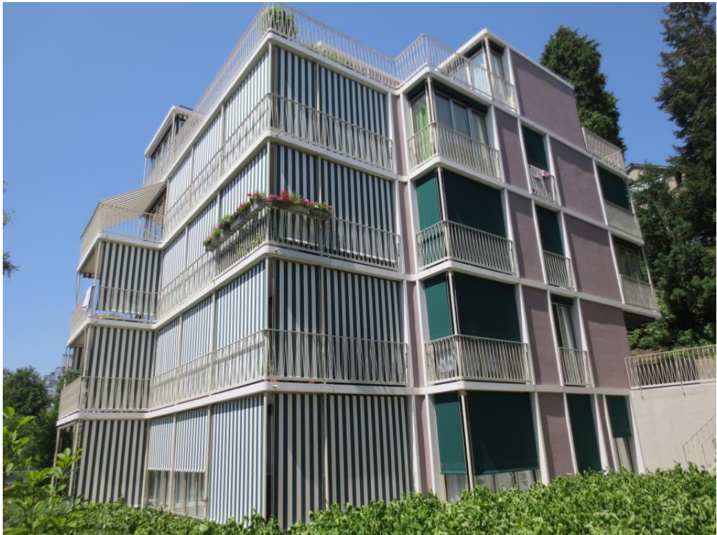
Abb. 10.1: Stark verglastes MFH mit Stoffstoren und Sonden-Freecooling (Geocooling)
