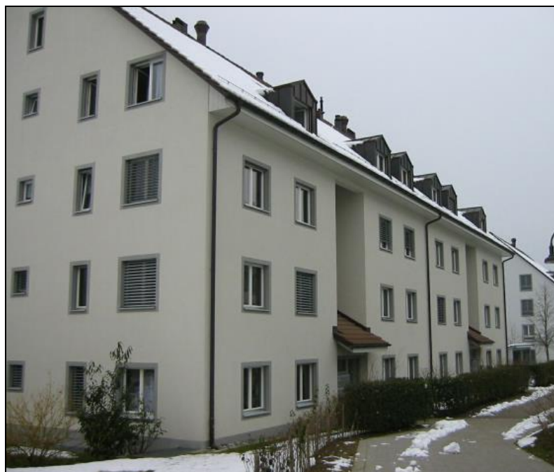
Abb. 6.1: MFH mit kalter EG-Wohnung und offenen Kippfenstern im OG
