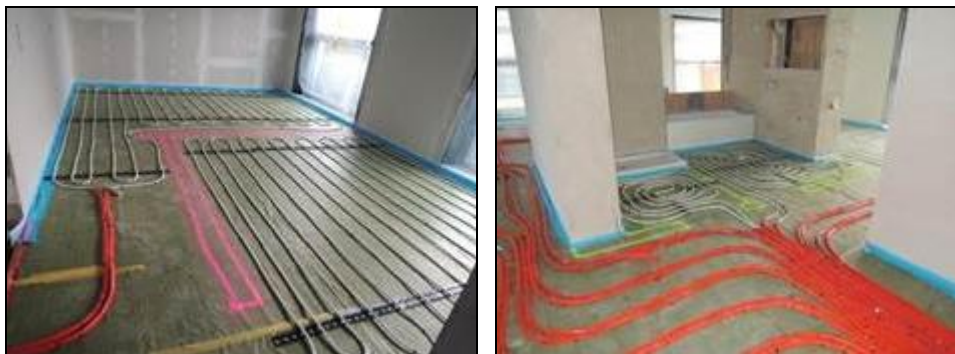
Abb. 2.24: Verlegung der Fussbodenheizungsrohre.
