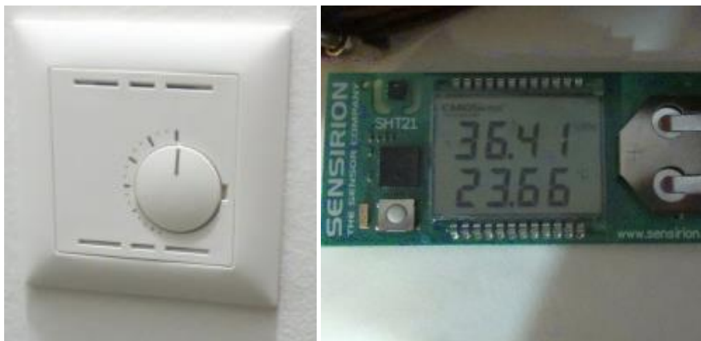
Abb. 2.13: links: Thermostat auf maximaler Einstellung, rechts: Raumtemperaturmessung, durchschnittlich Raumtemperatur liegt bei rund 23.5°C.
