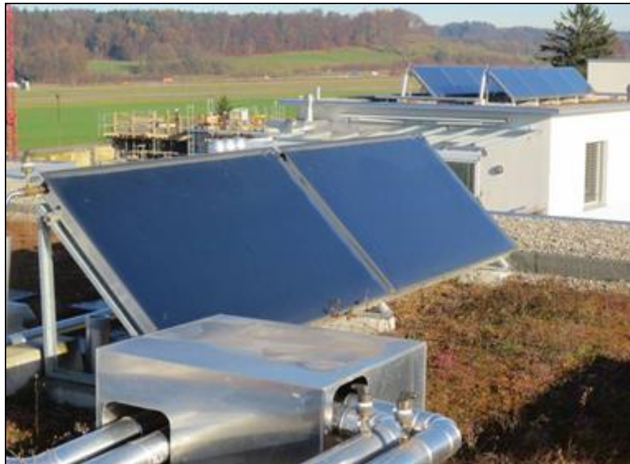
Abb. 1.24: Verglaste Flachkollektoren von Haus B, im Vordergrund der Dachdurchbruch für die Steigleitungen.
