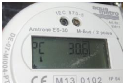
Abb. 2.15: Wärmezähler der FBH mit Vorlauftemperatur.
