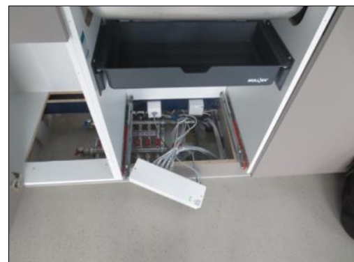
Abb. 3.3: Fenster der Westseite und Heizungsverteiler unter Spülbecken in der Küchenkombination
