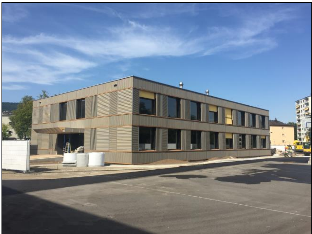
Abb. 8.1: Schulhaus mit trocken verlegter Fussbodenheizung Therm38
