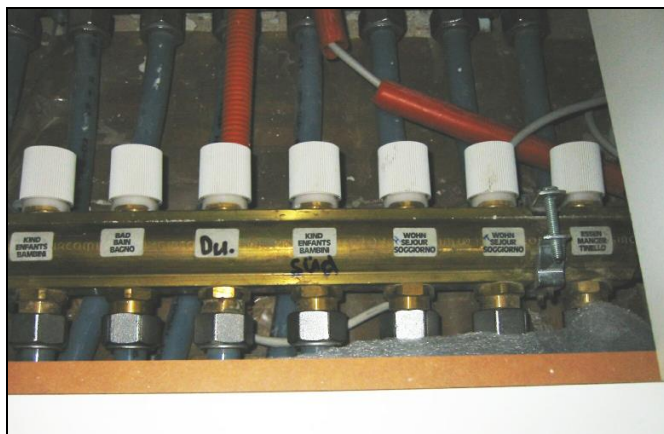
Abb. 6.3: Fussbodenheizungs-Verteiler
