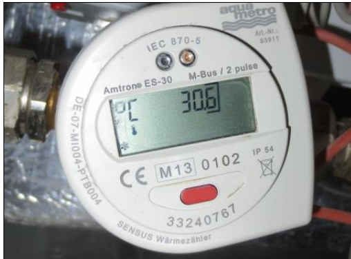
Abb. 2.20: Wärmehähler der FBH mit Vorlauftemperatur.
