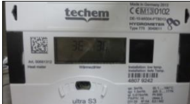
Abb. 1.5: Links der neu installierte Heizkreisverteiler im Gang, rechts der alte Heizkreisverteiler im Reduit.
