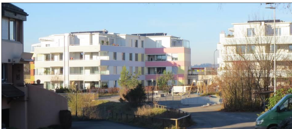
Abb. 1.2: Ansicht der Südfassaden, links das Haus D und rechts das Haus C.
