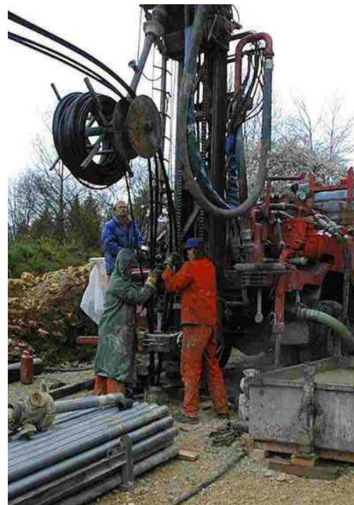
Bild 1.7 Einbau einer Erdwärmesonde (Foto: Grundag AG, Gossau).
