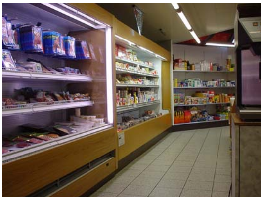
Bild 3.3: Kühlmöbel in der Beispielanlage (Foto: KWT AG).
