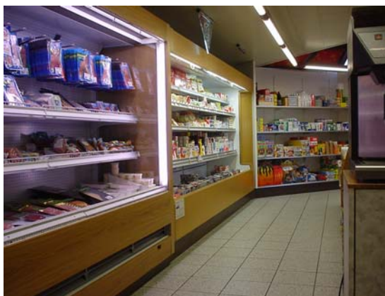
Bild 3.1: Kühlmöbel in der Beispielanlage (Foto: KWT AG).
