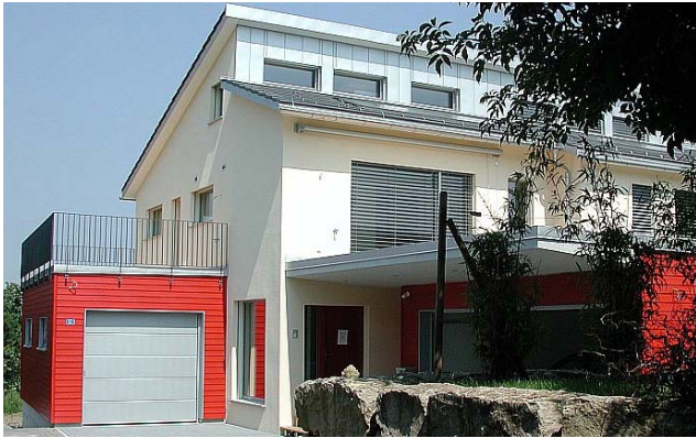
Bild 4: MINERGIE-P EFH „Im Haufland“ in Maur mit installiertem „Geocooling“ (Architektur: Fild+Partner GmbH; Planung HLK Huber Energietechnik AG, Zürich)
